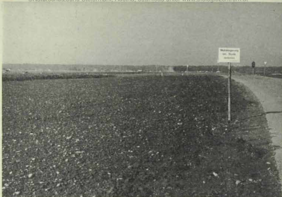
Mülldeponie verdichtet und abgedeckt.
