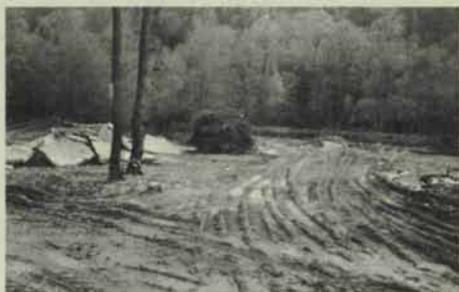
Abbruch- und Aushubmaterial wird an Altarme abgelagert (rechts im Bild) und dann planiert. Wertvolle Auen und Altarmgebiete für alle Zeiten vernichtet.
