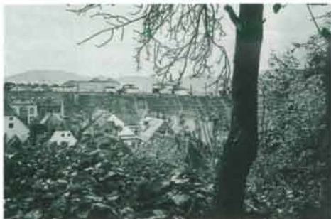
Blick vom Grazer Schloßberg auf die historische Dachlandschaft. Foto: Prügger
