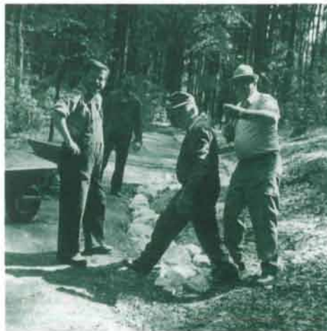
Sanierung von Gerinnen, Bild-Mitte: Bezirksleiter Gottfried Ritz.
