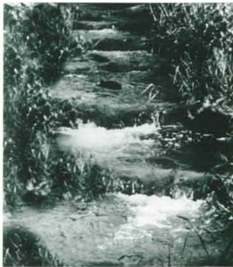
Fischaufstiegshilfe „Fladnitz“ (Clementmühle), errichtet 1998. Bisher konnten im Einvernehmen mit den Wassernutzungsberechtigten bei vier bestehenden Stauanlagen Fischaufstiegshilfen in Form von naturnahen, kaskadenförmigen Umgehungsgerinnen errichtet werden, die sich auch landschaftlich gut einfügen. Aufgrund des relativ großen Flächenbedarfes sind derartige Ausführungen leider nicht überall möglich.
