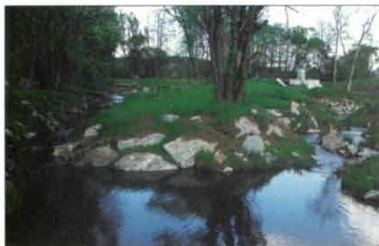
Mehr als 30 Becken bilden einen Tümpelpass, der sich im Bereich eines Altarmes rechtsufrig der Lafnitz erstreckt.
