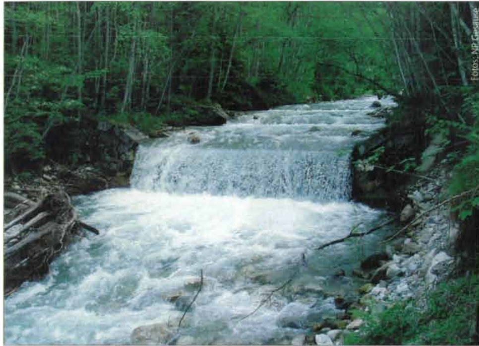
Solche harten Verbauungen im Johnsbach - weitab der Siedlungen - werden dank LIFE in Kürze nicht mehr zu sehen sein.
