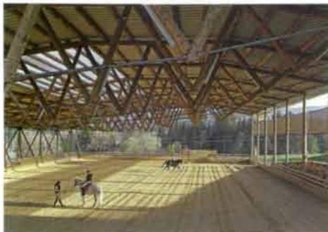
Dachkonstruktion eines stahl-unterspannten Rundholztragwerkes überdeckt die große Fläche des Reitplatzes. Das Ergebnis zeigt die Auseinandersetzung mit dem Baustoff Holz als Rohmaterial und dem Wissen in der statischen und architektonischen Umsetzung als Tragwerk. Es handelt sich um eine technisch innovative und gestalterisch vorbildliche Leistung.
