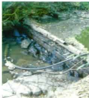
Einst unüberwindbar für kleine Fische, wurde diese Sohlschwelle nach dem Sturm „Paula“ rückgebaut.
