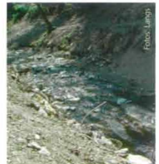
Einst unüberwindbar für kleine Fische, wurde diese Sohlschwelle nach dem Sturm „Paula“ rückgebaut.
