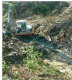
Einst unüberwindbar für kleine Fische, wurde diese Sohlschwelle nach dem Sturm „Paula“ rückgebaut.
