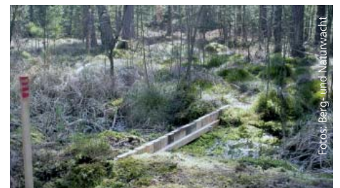
Berg- und Naturwächter beim Dammbau – durch die insgesamt neun Dämme wird das Abfließen des Grundwassers aus dem Moor verhindert.
