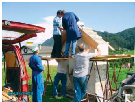
Die Männer der Ortseinsatzstelle Oberwölz bei den Restaurierungsarbeiten
