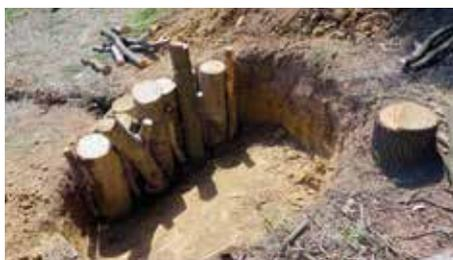
**4** Nun können bereits die Zwischenräume der ersten Reihe auf eine Höhe von ca. 40 cm mit Erde verfüllt werden. Hierbei ist das Füllmaterial lageweise einzubringen und durch Stampfen zu verdichten. Die ersten Reihen dienen zur Stabilisierung der hinteren, weiter herausragenden Stammstücke.
