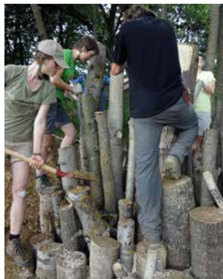
**6** Parallel dazu können die Zwischenräume bis auf Halbe Höhe der Grube verfüllt werden. Für die Stabilisierung der Stämme wird die frisch aufgefüllte Erde durch Stampfen verdichtet.
