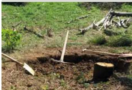
**2** Zuerst werden die 60 cm Stammstücke auf einer Seite, vorzugsweise hangabwärts, gesetzt und möglichst fest mit den Abstandhaltern, die eingeschlagen werden, fixiert.
