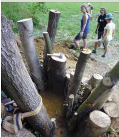
**5** Es folgt Reihe auf Reihe mit zunehmender Länge der Stammstücke. In der Mitte sollte ein Raum ohne Holz frei bleiben, der später mit einem Erde-Sägespäne-Gemisch aufgefüllt wird.
