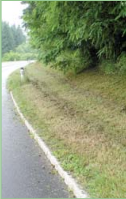
An Bundesstraßen werden die Böschungen oft in einer Breite von mehreren Metern geschlägelt.
