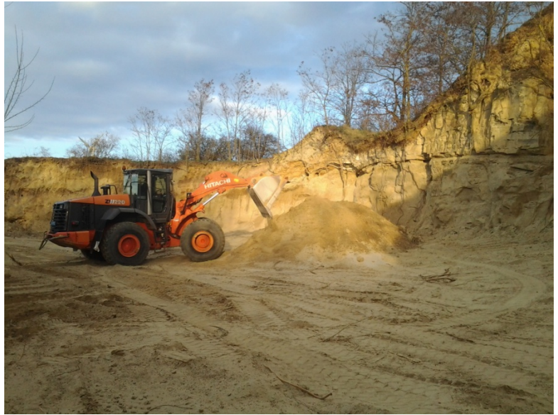
Abb. 7: Aufbringung und planieren von sandigem Material
