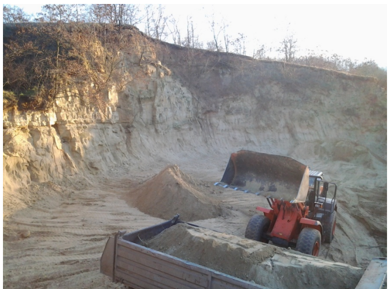
Abb. 6: Abtransport abgerutschten Materials
