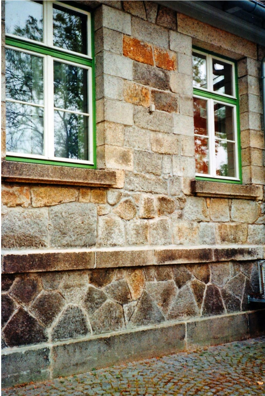
Abb. 3: Bahnhofsmauerwerk aus Syenit und Granit mit deutlicher Mustergebung am-Hauptgebäude. Muster- und Gliederungselemente Granit, der Rest Syenit.
