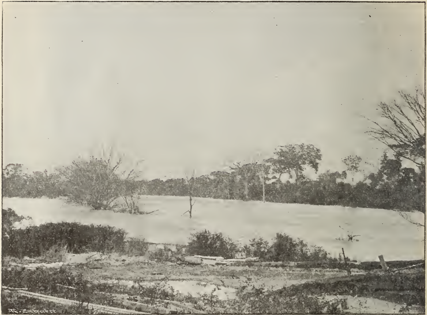
Textfig. 7a. Der Übergang über den stark verbreiterten, versandeten Rio Ocosito bei Caballo blanco vermittelt einer Seilbrücke (Garrucha). Aufgenommen von R. SAPPER, October 1903.
