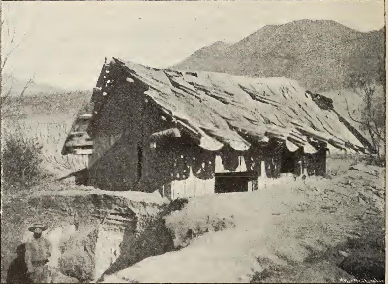
Textfig. 1. Kaufladen bei El Nil, ca. 6 km WSW. vom Krater (zeigt die Durchlöcherung der Dächer). Aufgenommen im Januar 1903 von Herrn MOESLI.
