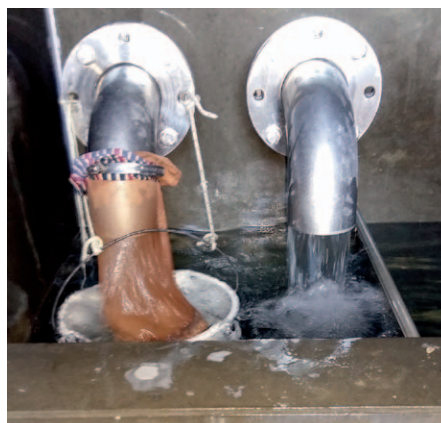
Quelle bei Guggental, Gaisberg. Linkes Rohr mit Damenstrumpf.
