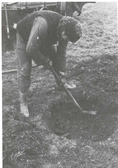
Abb. 37 5. Auflockern der Ränder nach Erreichung der Tiefe
