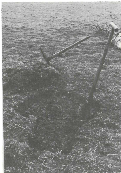
Abb. 35 3. Lagerung des Oberbodens getrennt vom Unterboden neben der Pflanzgrube
