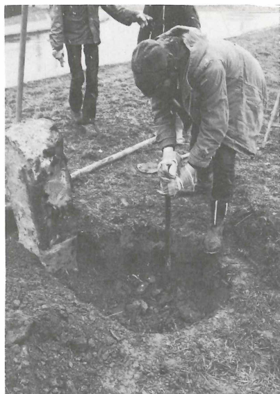
Abb. 39 7. Mit einer Brechstange wird das Loch für den Pfahl vorgebohrt
