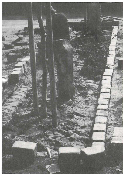
Abb. 18 Setzen der Läufer- reihe (Granit 17 Großpflaster)
