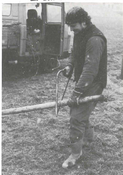
Abb. 40 8. Kürzung des Pfahls auf erforderliche Länge (Für Baumstärken bis 14/16 StU genügt einfache Pfählung)
