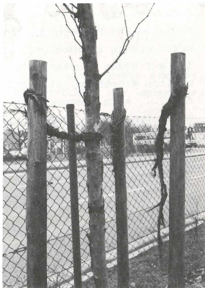
Abb. 78 Pfähle stehen zu weit auseinander, Instabilität wegen fehlender Querriegel, zu lange Bindung - durch Winddruck abgerissen
