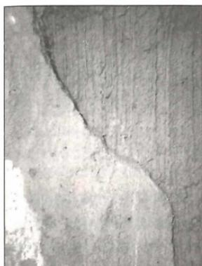
Abb. Lehmputzschaden durch rabiaten Tapetenabtrag.
