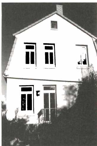
Ansicht des Mansarddachhauses, rückwärtige Seite
