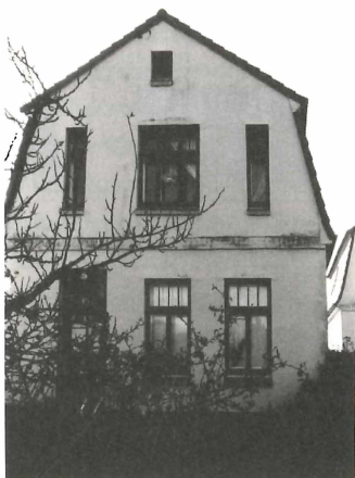
Ansicht des Mansarddachhauses in Cuxhaven, Straßenseite
