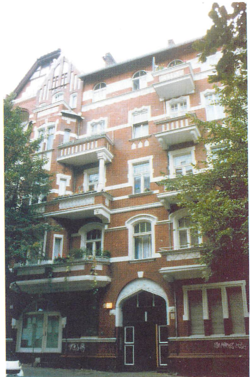
Abb. 13. Berlin, Haus Isarstraße Nr. 3: Straßenansicht
