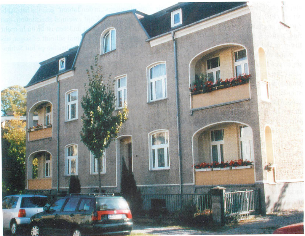
Abb. 21. Königs Wusterhausen, Haus Waldstraße Nr. 22: Gesamtansicht
