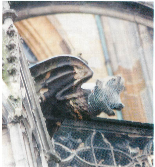
Abb. 5. Ulm, Münster: Wasserspeier Nordseite
