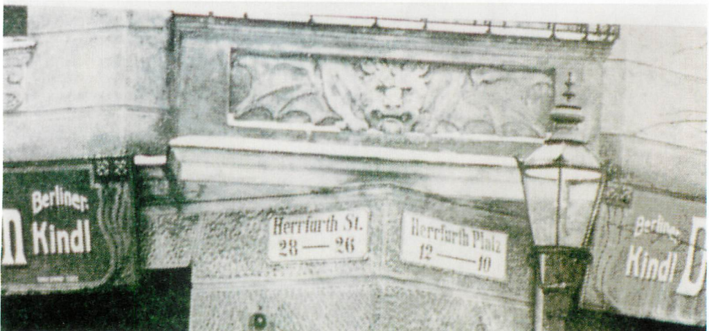
Abb. 11. Berlin, Haus Herrfurthstraße/Ecke Herrfurthplatz (1909)
