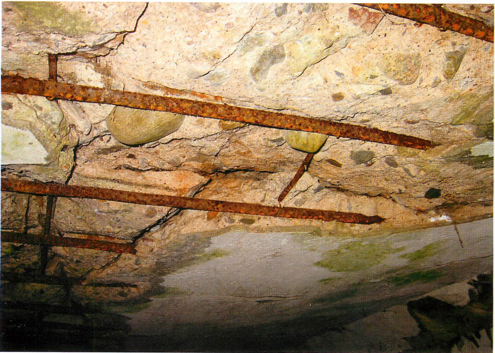
Abb. 2. Detailansicht eines Betongangs mit Sprengissen im Deckenbereich. Aufn.: H. POMMERANZ
