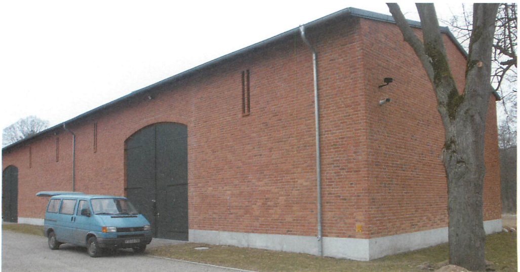
Abb. 3. Wolletz. Neues Wochenstubengebäude am alten Standort. Der Mausohrraum wurde hinter dem oberen Giebelbereich eingebaut. Aufn.: TORSTEN BLOHM
