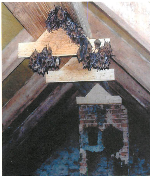
Abb. 7. Gatow. Von Mausohren wiederbesiedeltes Wochenstubenquartier nach dem Einziehen eines Zwischenbodens und Installation von Hangmöglichkeiten. Aufn.: JÖRN HORN
