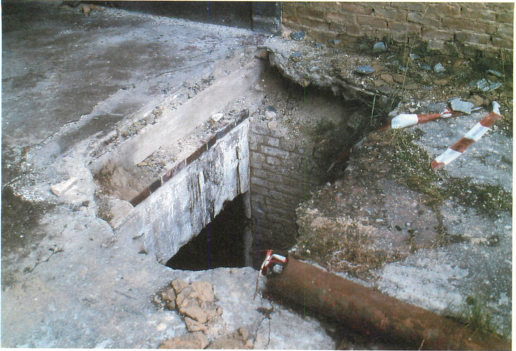
Abb. 3. Nahaufnahme des Haupteinflugbereiches unter der eingefallenen Fahrspur. Deutlich sind die Betonteile der Decke der erhaltenen unterirdischen Teile des ehemaligen Heizhauses sichtbar. Aufn.: U. HERMANN'S
