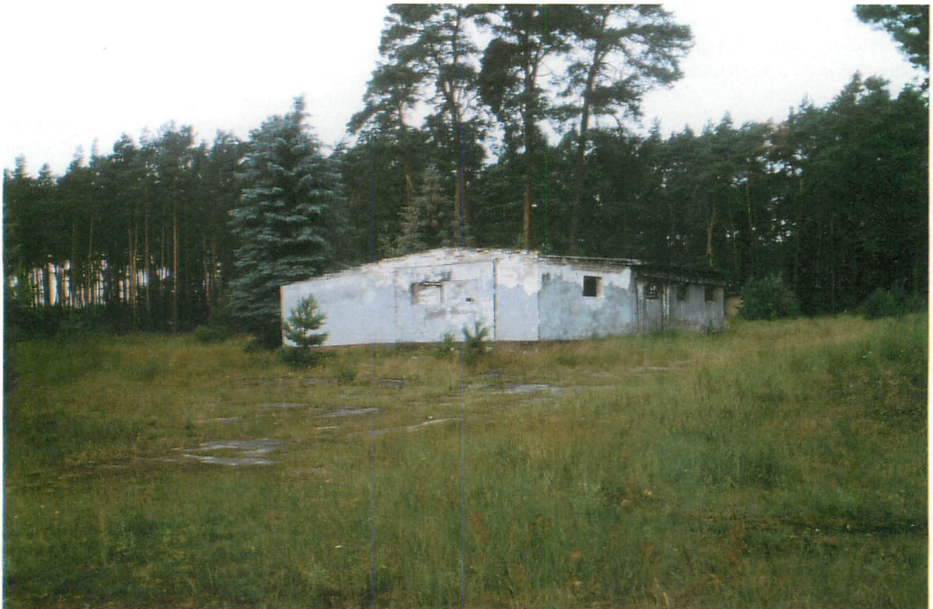
Abb. 1. MUNA Fürstensee/Gebäude 130, welches durch die sowjetischen Truppen als KFZ-Werkstatt genutzt wurde. Das Bauwerk steht auf einem abgetragenen deutschen Heizhaus der ehemaligen Heeres-Munitionsanstalt Fürstensee. Aufn.: U. HERMANN
