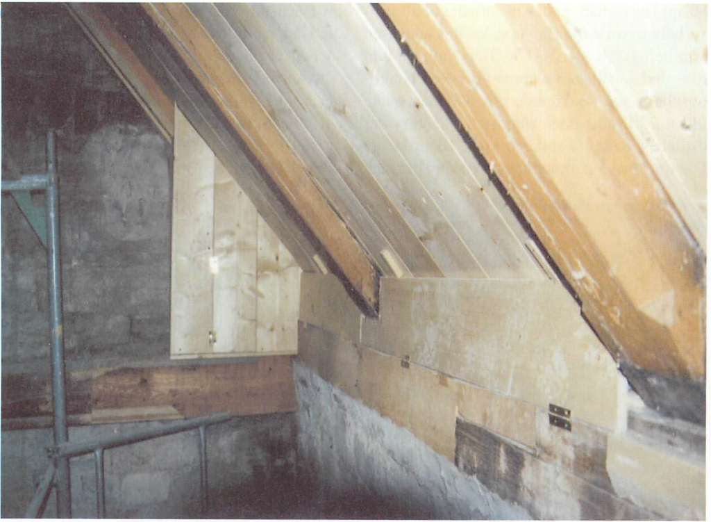
Abb. 12. Pfarrkirche in Gehofen; Innendach mit Kotrinnen und Balkenkastenquartier. Aufn.: A. DANZ
