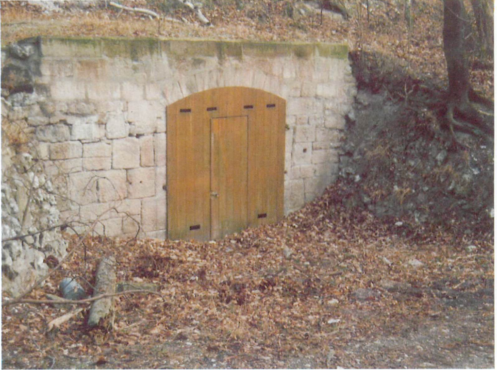
Abb. 14. Saniertes Winterquartier der Mausohren, ein Lagerkeller. Aufn.: W. SAUERBIER
