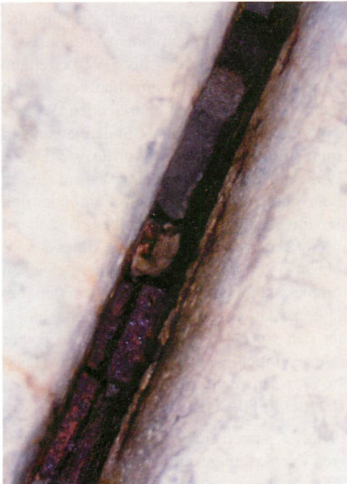
Abb. 1. Mausohr-♂ A 46063 in breiter Spalte zwischen verschraubten Deckensegmenten in Fürstenwalde-SW/Bunker Kiesweg. In solchen Spalten hielten sich dort auch die Paarungsgruppen auf. Aufn.: L. ITTERMANN, 20.X.2004
