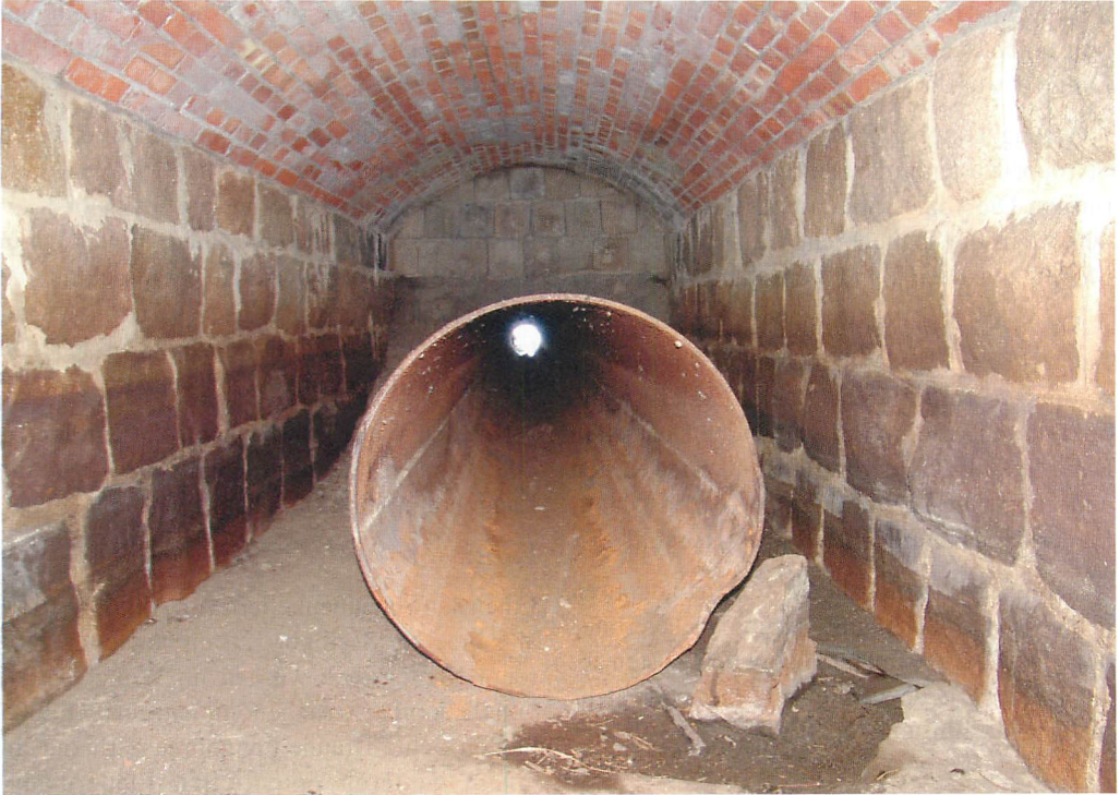
Abb. 2. Verschlüssener Zugang auf der anderen Seite der großen Eisenbahnunterführung Görlsdorf, von innen gesehen, mit an der Sohle eingelassenem, 60 cm starkem Rohr. Deutlich ist auch zu erkennen, daß die Spalten zwischen den Klinkern und Feldsteinen sauber verschmiert wurden.
