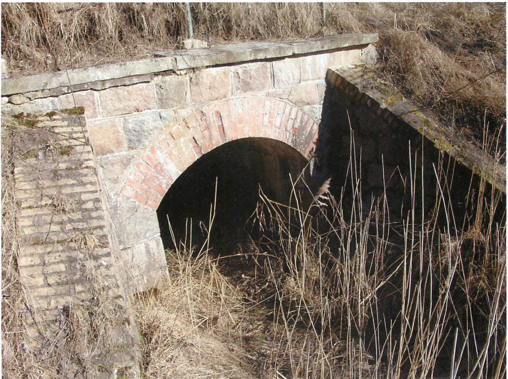
Abb. 1. Offener Zugang zur großen Eisenbahnunterführung Görlsdorf. Alle Aufn.: J. HORN
