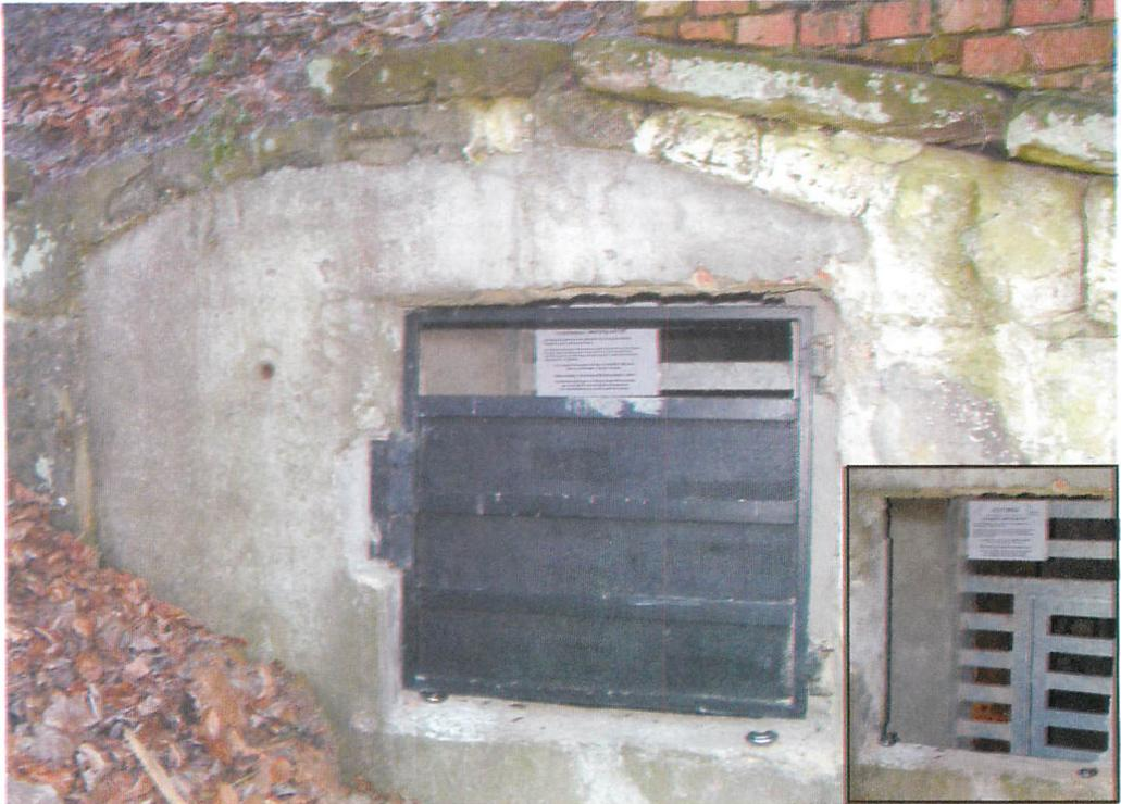
Abb. 10. Doppelte Sicherung des mehrfach aufgebrochenen Brauereikellers Cortendorf im FFH-Gebiet "Veste Coburg, Bausenberger und Callenberger Forst" (kleines Bild mit geöffneter erster Tür). Aufn.: G. HÜBNER
