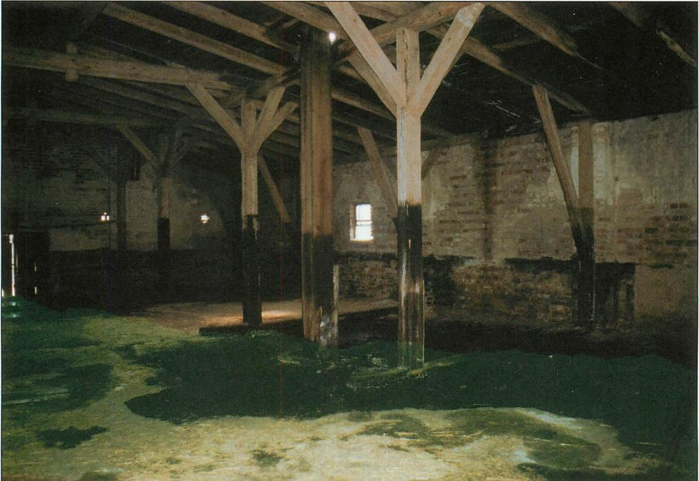
Abb. 7. Zustand des ursprünglich zur Lagerung von Rohfutter dienenden Dachbodens über den Stallräumen vor der Sanierung (2000/2001). Durch die bauffällige Dachhaut regnete es durch, und es bestand an einigen Stellen akute Einsturzgefahr. Aufn.: U. GRÜTZMACHER
