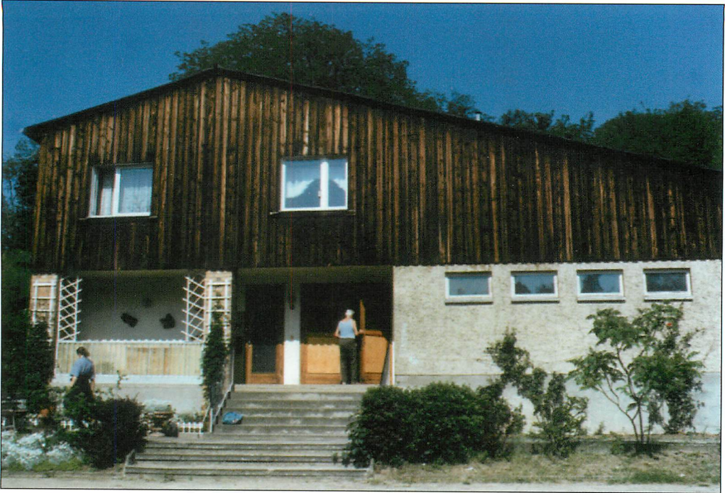
Abb. 5. Schule in Pritzhagen/OT Haus Tornow. Hinter der versetzt genagelten Holzverkleidung des breiten Giebels halten sich zahlreiche Breitflügel-Fledermäuse ( Eptesicus serotinus ) auf – eine Wochenstubengesellschaft? Aufn.: ULRICH TIGGES, 1.VI.1994
