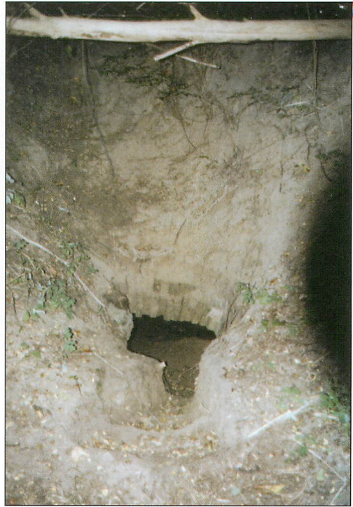
Abb. 5. Eingang zum „Bergkeller“ vor den Sicherungsarbeiten. Aufn.: M. NÄFE, 2005
