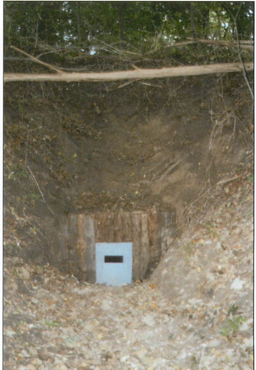
Abb. 6. Eingang zum „Bergkeller“ nach den Sicherungsarbeiten. Aufn.: M. NÄFE, 2005
