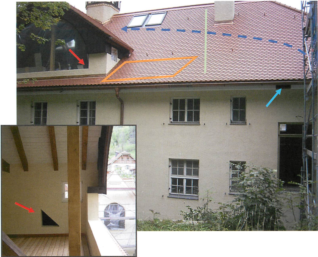
Abb. 3. Situation nach dem Umbau 2004 (Ansicht der Gebäuderückseite). Grün: Grenze zwischen dem Wohnbereich (links) und dem Fledermausbereich (rechts). Gestrichelte blaue Linie: Früherer Flugweg zur Ein- und Ausflugsöffnung. Hellblauer Pfeil: Neue Öffnung, die den Tieren aus dem Vorjahr 2003 nicht bekannt war und die nicht genutzt wird. Rote Pfeile (großes und kleines Bild): Zusätzliche Öffnung in der Seitenwand der Dachterrasse (hier bestand 2003 eine große Öffnung im Dach), die von den Tieren angenommen wurde. Orange: Toter Raum, der eine Flugwegverbindung zwischen der neuen Öffnung in der Seitenwand der Dachterrasse und dem Fledermausbereich vorbei am Wohnbereich ermöglicht.
