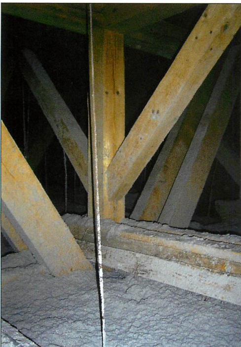
Abb. 4. „Verstaubtes“ Hauptquartier infolge der Wärmedämmung.
