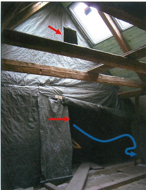
Abb. 2. Provisorisch mit Folie abgetrennter Fledermausbereich (linkes Bild) mit ständiger Durchflugsöffnung (roter Pfeil oben) und nachts geöffnetem Bereich (roter Pfeil unten). Zukünftiger Wohnbereich (rechtes Bild), vom Fledermausbereich aus gesehen, mit zukünftiger Dachterrasse (gelber Pfeil) und ursprünglicher Aus- und Einflugsöffnung (grüner Pfeil). Der Flugweg der Tiere bis zur Öffnung ist durch blaue Pfeile angedeutet.
