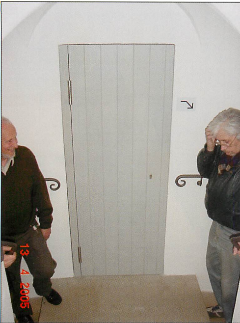
Abb. 9. Gegen Störungen von außen schallgedämmte Tür vom Treppenhaus in die wieder aufgebaute Abendsegler-Kammer. Aufn.: U. DINGELDEY
