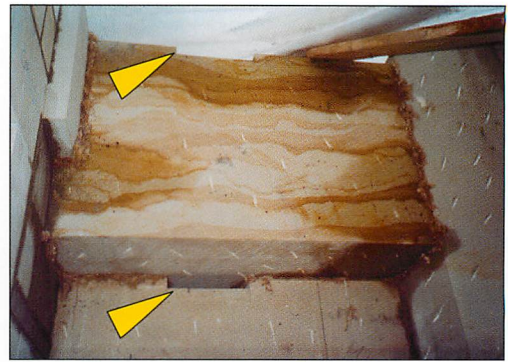
Abb. 10. Während der Bauphase: Blick aus dem Innenraum der Abendsegler-Kammer auf die beiden übereinander positionierten Einflugschlitze (Pfeile). Aufn.: Dr. D. BRANDES
