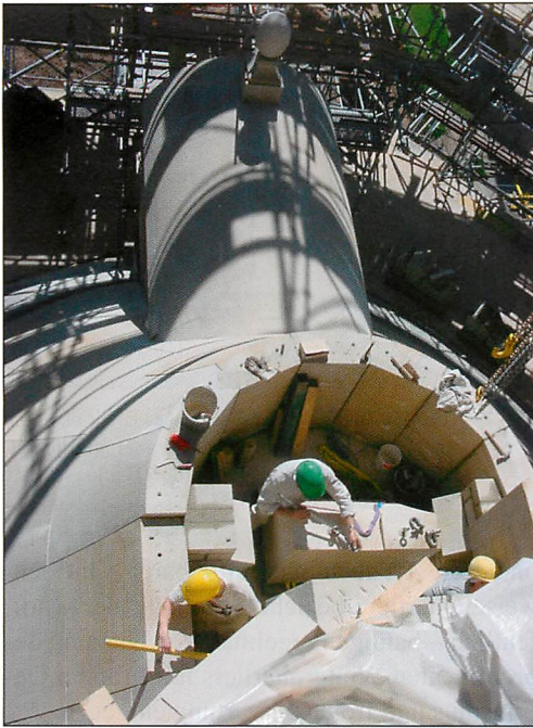
Abb. 7. Blick von oben auf die untere Schicht der wieder entstehenden Kammer während der Aufbauphase. Aufn.: Dr. D. BRANDES
