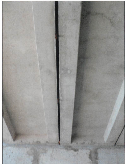
Abb. 7. Deckenspalten in einer Einrichtung zur Ableitung von Düsenjäger-Abgasstrahlen.
