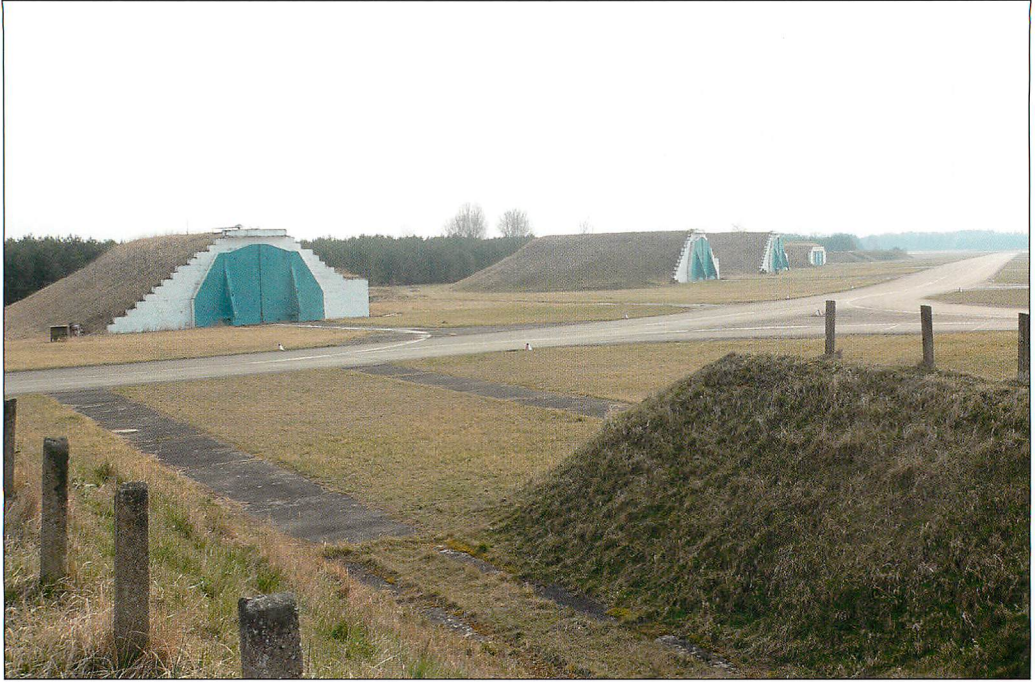
Abb. 2. Längs einer Start- und Landebahn aufgereichte geschlossene Flugzeugdeckungen (= Hangars) und LKW-Garagen. Außer Abb. 9 alle Aufn.: Dr. J. HAENSEL.
