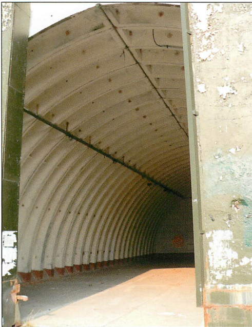
Abb. 4. Blick durch die geöffneten riesigen Flügeltore in das Innere eines Hangars mit der typischen Segment-Struktur.
