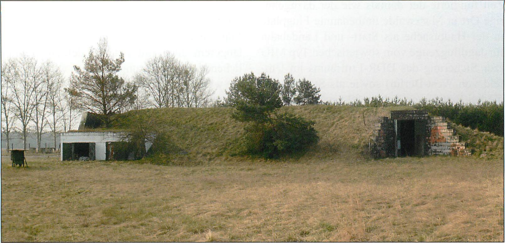
Abb. 6. Einrichtung zur Ableitung der Düsenjäger-Abgasstrahlen im hinteren Bereich der geschlossenen Flugzeugdeckungen (rechts).
