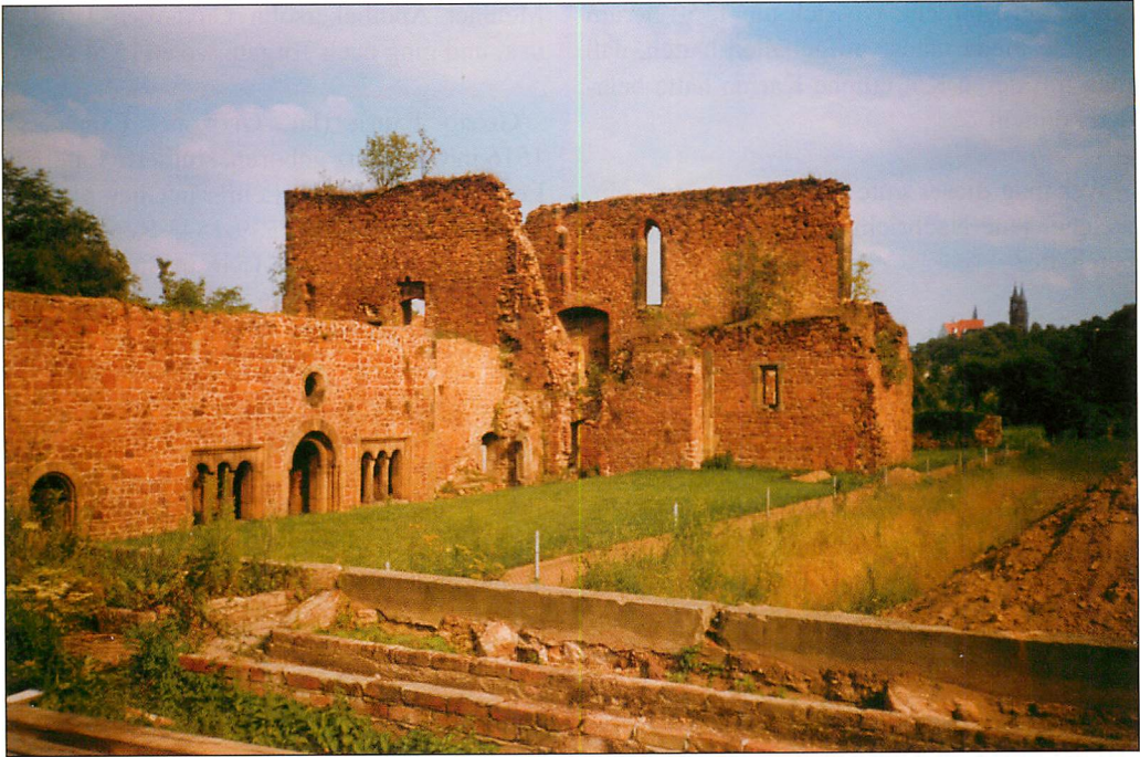
Abb. 4. Nach dem Zusammenbruch der DDR wurde ein Verein zur Rettung der Klostersruine gegründet, welcher (mit seinen bescheidenen finanziellen Mitteln) die Erhaltung und Sanierung des Gemäuers vorantreibt und auch den Klostergarten zu neuem Leben erweckt.
