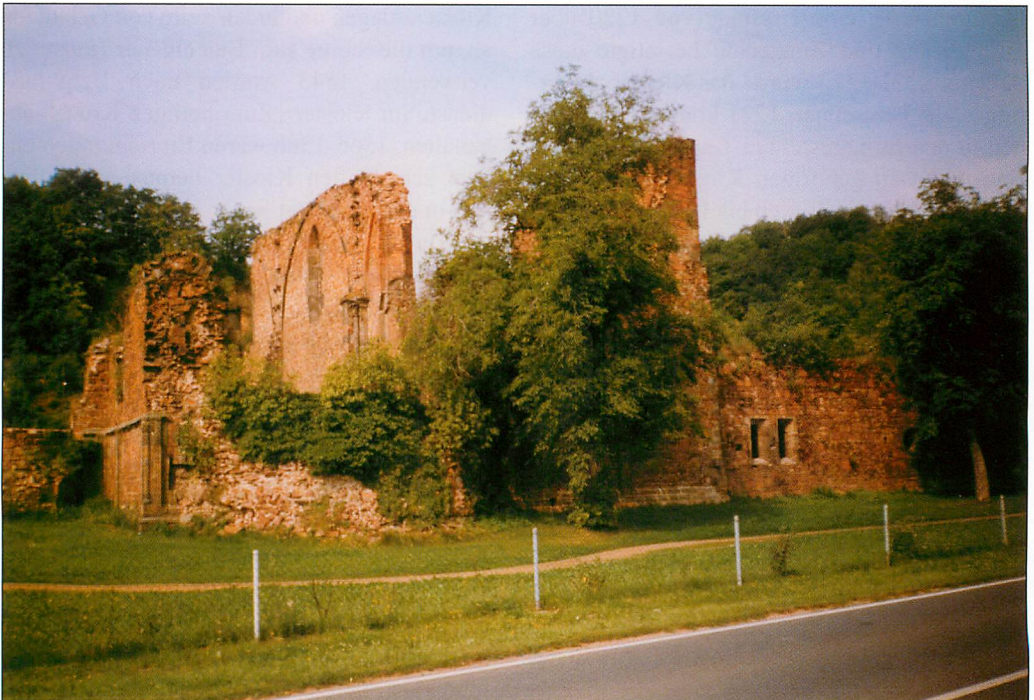
Abb. 3. Auch zur DDR-Zeit wucherten Bäume und Pflanzen auf dem Ruinengelände und auf den Mauern, es wurden keine Maßnahmen zur Erhaltung des Mauerwerks ergriffen.
