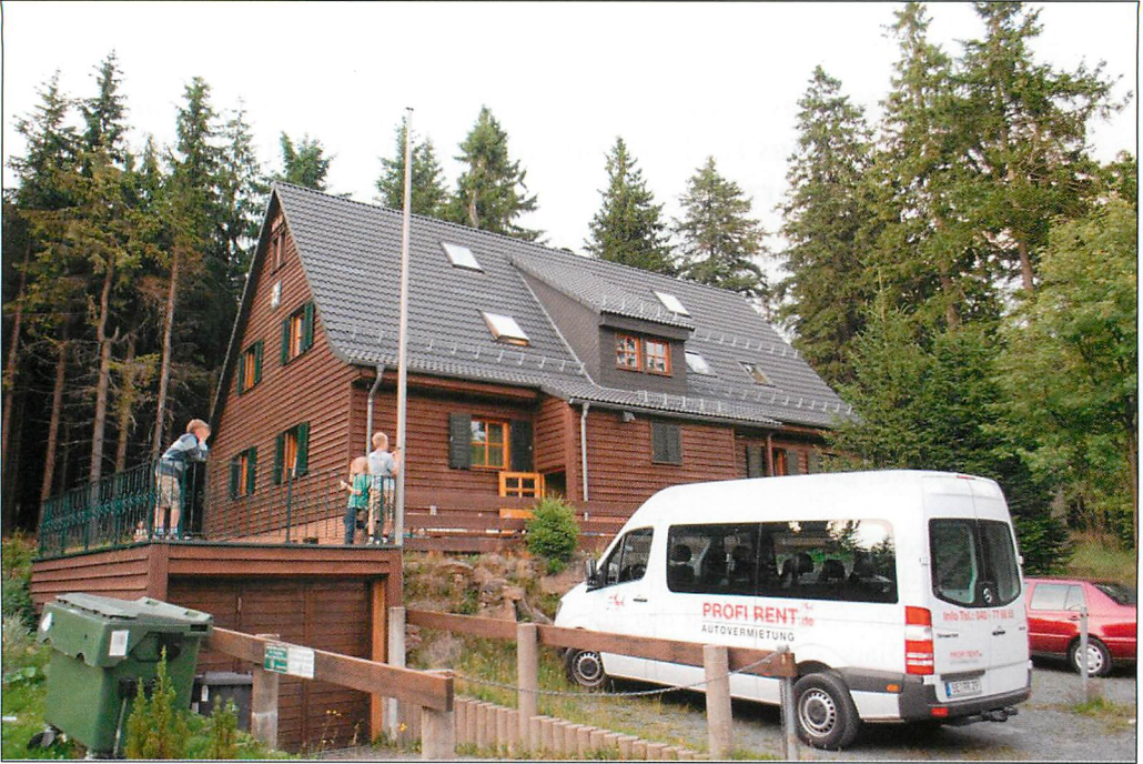
Abb. 1. Hinter der Bretterverkleidung dieses Gebäudes (am Vorbau in der Hausmitte, teils vom Fahrzeug verdeckt) befindet sich in Oderbrück (Oberharz) das Quartier der Männchengesellschaft der Zweifarbfledermäuse ( Vespertilio murinus ). Aufn.: T. v. ZENGEN
