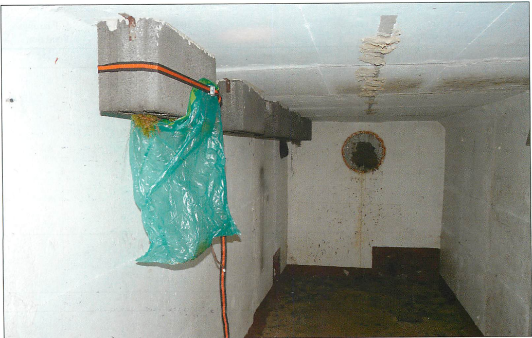
Abb. 1. Ehemaliger Telekom-Bunker Pehlenbruch in der Schorfheide mit fünf an der Decke befestigten Hohlblocksteinen aus Beton. Im vorderen (mit Abfangbeutel) hielten sich 17 der 18 in diesem Raum anwesenden Braunen Langohren ( Plecotus auritus ) auf. Alle Aufn.: PETER WITT
