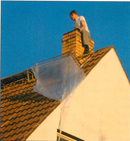
Abb. 2. Abfangeinrichtung („Harfe“) mit Seitenaufsätzen und einem aus weichem Plastikmaterial bestehenden, schlauchartigen Einsatz zur schonenden „Weiterleitung“ der Tiere nach unten in die Netzbeuteln.
