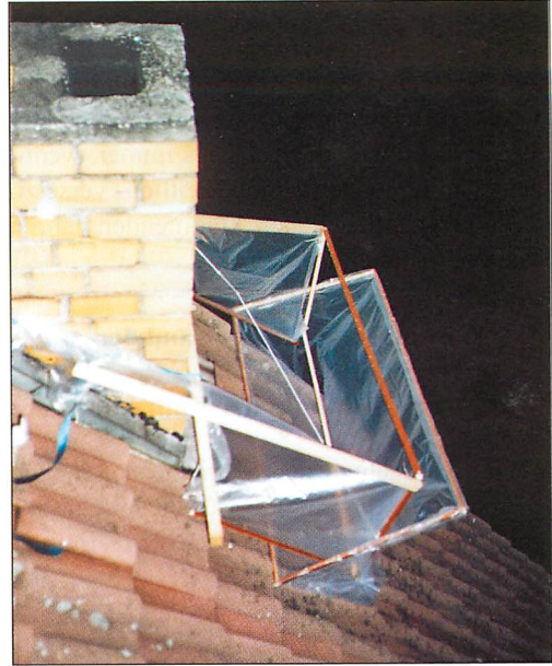
Abb. 6. An der Blecheinfassung des Schornsteins angebrachte Abfangeinrichtung („Harfe“ - verändert) vom Dachfirst aus gesehen. Beachte die hochgezogenen Seitenflügel, die ein seitliches „Ausbrechen“ der Tiere verhindert. Aufn.: LUTZ ITTERMANN
