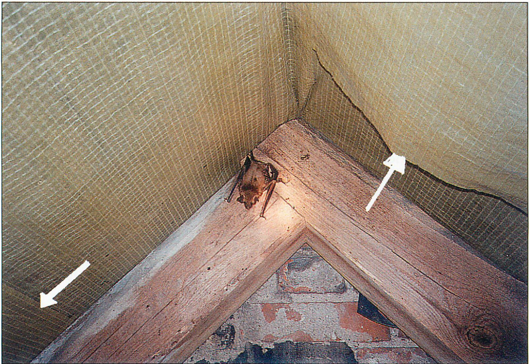
Abb. 1. Der neue Hangplatz der Mausohren auf dem Dachboden in Gatow vor der Wiederbesiedlung. Man erkennt, daß der Balken noch sauber ist. Pfeile kennzeichnen möglicherweise weitere vorhandene Spalten als Zugänge unter die Unterspannfolie. Alle Aufn.: JÖRN HORN.
