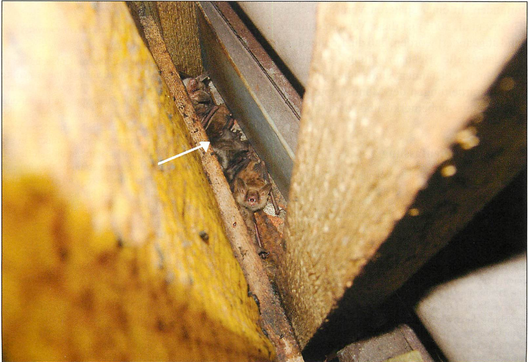
Abb. 3. Mausohren am Schornstein, dem dank vorhandener Spalten hauptsächlich genutzten Zugang unter die Folie in den Dachraum. Auf der linken Seite ist zu sehen, daß einige Tiere (Pfeil) mit dem Hinterleib unter der Folie sitzen.
