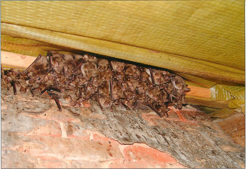
Abb. 4. Mausohren der Wochenstubenquartiers Gatow halten sich über der Unterspannfolie im Firstbereich auf.
