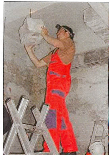
Abb. 37. Dönitzbunker: Montage von Hohlblocksteinen im Deckenbereich.
