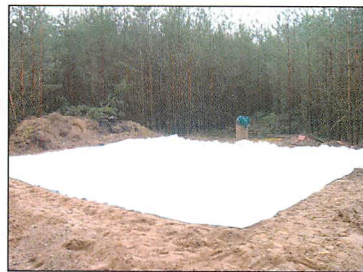
Abb. 32. Einbau von Vlies zur Sammlung des Regenwassers.
