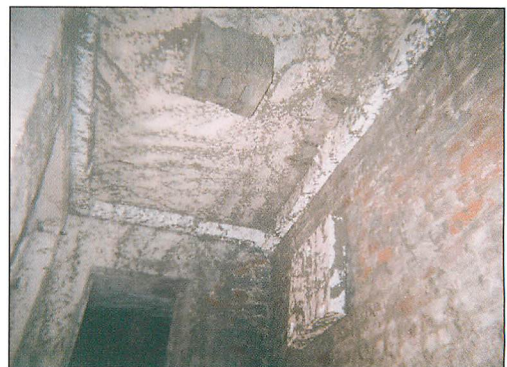
Abb. 49. Bunker „Sella Nord“/Königsbrücker Heide: Hohlblocksteine, Styroporplatten und Putzbewurf zur Erhöhung des Versteckangebots.
