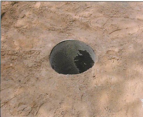
Abb. 34. Sammelrohr, in das die Folie entwässert (wurde unter Flur perforiert).
