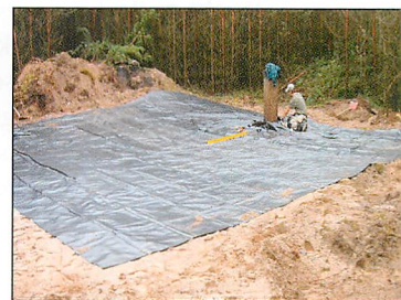
Abb. 33. Einbau von Folie zur Sammlung des Regenwassers.
