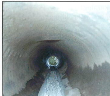
Abb. 26. Maßnahme zur Verbesserung der Bewetterung.
