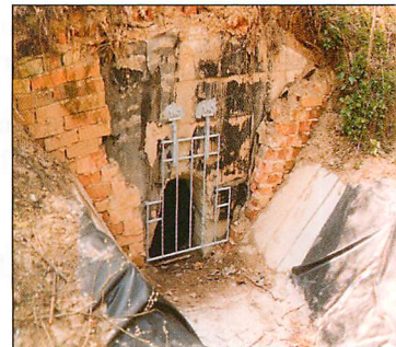
Abb. 27. Maßnahme zur Verbesserung der Bewetterung.
