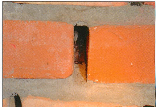
Abb. 10. Fransenfledermaus ( Myotis nattereri ) in neu errichtetem Pfeiler mit offener Längsfuge.
