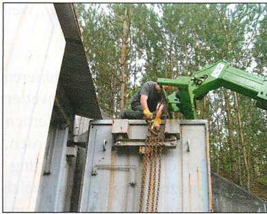
Abb. 22. Einhängen des Tores mit Teleskoplader und Spezialketten.
