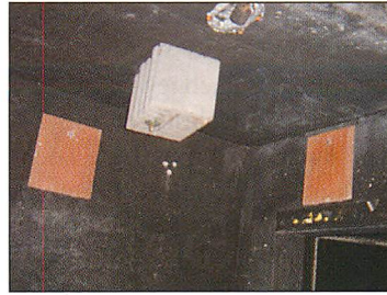
Abb. 4. Anbringen von Dachziegeln neben Hohlblocksteinen im deckennahen Bereich.
