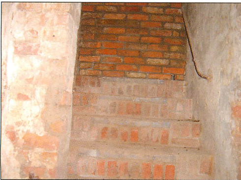
Abb. 44. Brauereikeller Anklam: Von außen nicht mehr zu erkennen, der vermauerte, ehemalige Treppenzugang..
