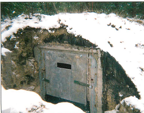
Abb. 11. Bunker in Neudorf/Spree (Sachsen). Die Türen wurden mit dem Rahmen verschraubt, die Eingangsbereiche anschließend mit Sand verfüllt.
