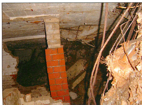
Abb. 46. Bunkerkomplex Saßnitz-Dwasieden: Stützen im Deckenbereich zur Sicherung des Quartiers und als neue Versteckmöglichkeiten.
