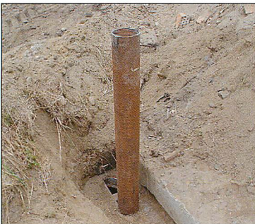
Abb. 25. Maßnahme zur Verbesserung der Bewetterung.
