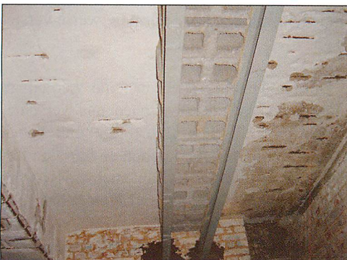
Abb. 1. Großkammersteine auf Doppel-T-Trägern.
