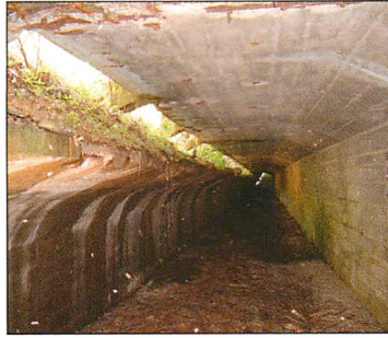
Abb. 29. Beispiel für das Vermauern von Türen.
