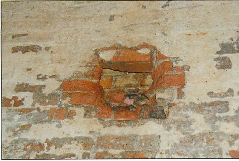
Abb. 8. Einer von mehreren gewaltsamen Durchbrüchen durch die doppelten Ziegelwände der Ostquellbrauerei. Aufn.: N. BARTEL.
