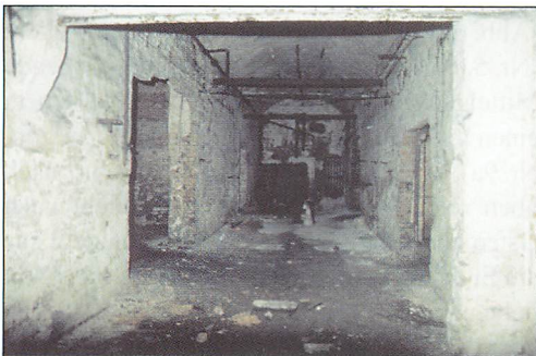
Abb. 2. Ostquellbrauerei/untere Kellerebene: langer Mittelgang (Nr. 4), rechts die Durchgänge in die Hallen Nr. 1-3, links die Durchgänge in die Hallen Nr. 5 und 6, hinten links der Durchgang in die Halle 10, rechts eine Gittertür vor den Räumen Nr. 11 und 11a; von dort führt der Weg ins Treppenhaus. Aufn.: L. ITTERMANN.
