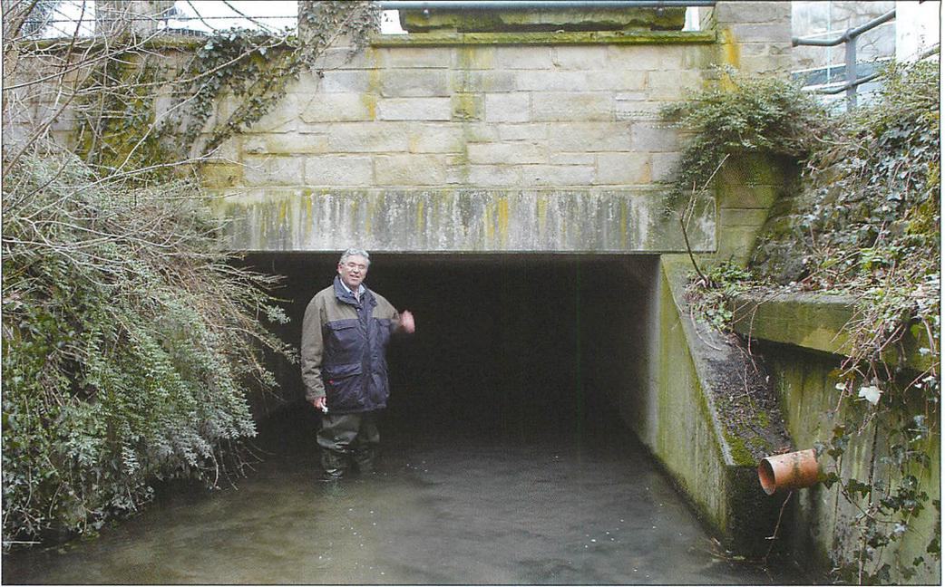
Abb. 2. Bachdurchfluss der „Neuen Exter“. Betongefasstes Mundloch des Wassereinlaufs. Alle Aufn.: CHRISTIAN ABEL.
