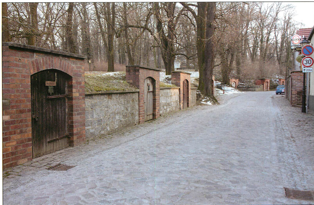
Abb. 1. Schlieben, Martinstraße („Kellerstraße“): Eingangsbereiche zu einem Teil der Weinkeller am Martinsberg. Aufn.: T. KUNZE.
