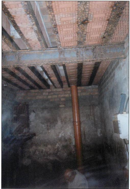
Abb. 10. Deckenansicht von Quartier Nr. 10 mit den Porotonbetten. An der hinteren Wand ist das Lüftungsrohr sichtbar.
