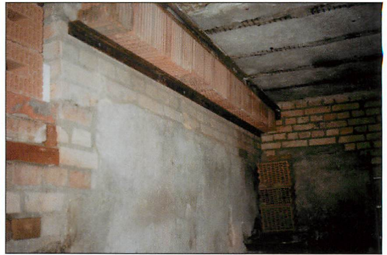
Abb. 9. Die linke Reihe von Porotonbetten ist unter der Decke von Quartier Nr. 10 angebracht.
