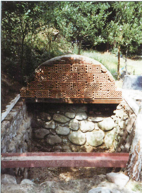
Abb. 24. Quartier Nr. 15. Fertiggestellter hinterer Gewölbekeller.
