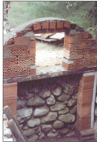
Abb. 25. Quartier Nr. 15. Vorderer Gewölbekeller mit Kontrolltüröffnung.
