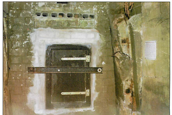
Abb. 42. Betontür zum Winterquartier Hitzacker Fasskeller unmittelbar nach der Umrüstung.
