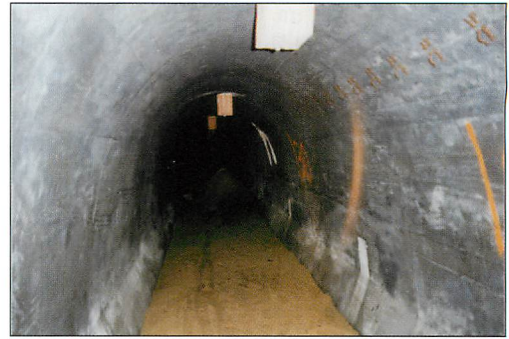
Abb. 14. Winterquartier Nr. 11: Bleckede. Blick in den hier bereits besandeten Tonnengang.
