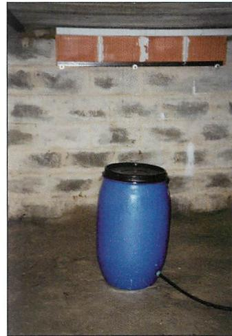
Abb. 22. Quartier Nr. 13. An der hinteren Wand ist unter der Decke eine Porotonbettenreihe zu sehen. Die Tonne sammelt das von der Regenfanganlage tropfende Wasser und verteilt es über einen Perlschlauch zu gleichen Teilen auf beide Räume.
