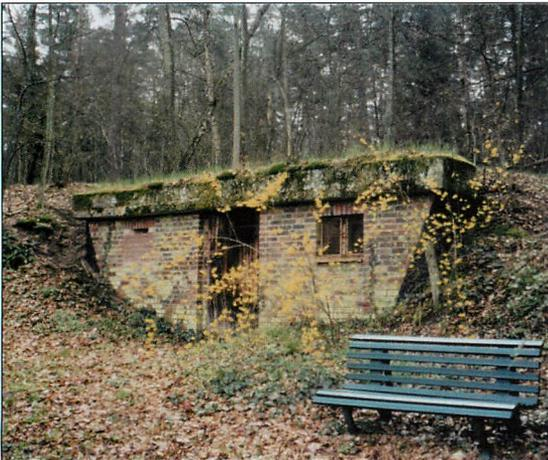
Abb. 20. Winterquartier Nr. 13: Dübbeckold Heidehauskeller. Ansicht von der Straße. Hier ist bereits das linke Fenster vermauert. Deutlich ist der Einkriechschlitz für Fledermäuse erkennbar.
