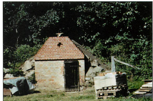
Abb. 12. Das Brunnenhaus, Quartier Nr. 10, nach dem 3. Ausbau.
