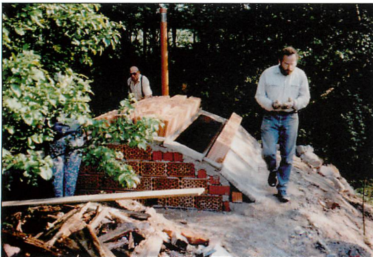
Abb. 4. Gewölbedecke von Quartier Nr. 5 im Bau. Porotonblöcke mit eingearbeiteten Nischen sind aufgelegt, im Hintergrund ist das Lüftungsrohr sichtbar.
