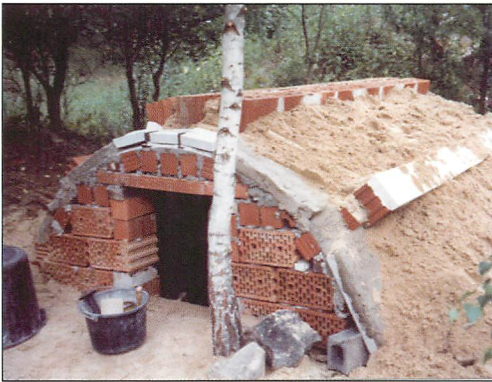
Abb. 28. Quartier Nr. 15. Die Deckplatten wurden auf die Porotonblöcke geklebt und die Übererdung erfolgte zunächst mit gewaschenem Sand von ca. 30 cm Schichtdicke und danach mit ca. 40 cm Mutterboden.
