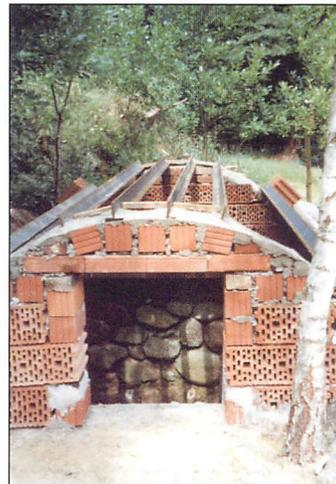
Abb. 26. Quartier Nr. 15. Aufgelegter Stützträger für die Porotonblöcke.
