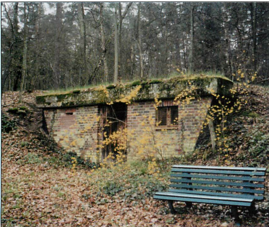
Abb. 20. Winterquartier Nr. 13: Dübbeckold Heidehauskeller. Ansicht von der Straße. Hier ist bereits das linke Fenster vermauert. Deutlich ist der Einkriechschlitz für Fledermäuse erkennbar.
