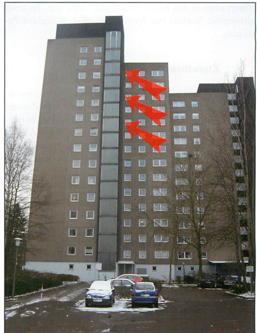
Abb. 1. Hochhaus in Kaiserslautern, an dem regelmäßig Abendsegler ( Nyctalus noctula ) in die Loggien der oberen Etagen einfliegen. (Die Einflugbereiche sind mit Pfeilen markiert.) Alle Aufn.: Dr. G. PFALZER.
