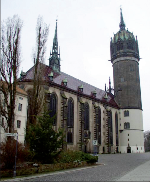
Abb. 1. Schlosskirche in Lutherstadt Wittenberg; unter dem Turm befindet sich ein Rundkeller mit sich anschließender Gruft. Aufn.: J. BERG.
