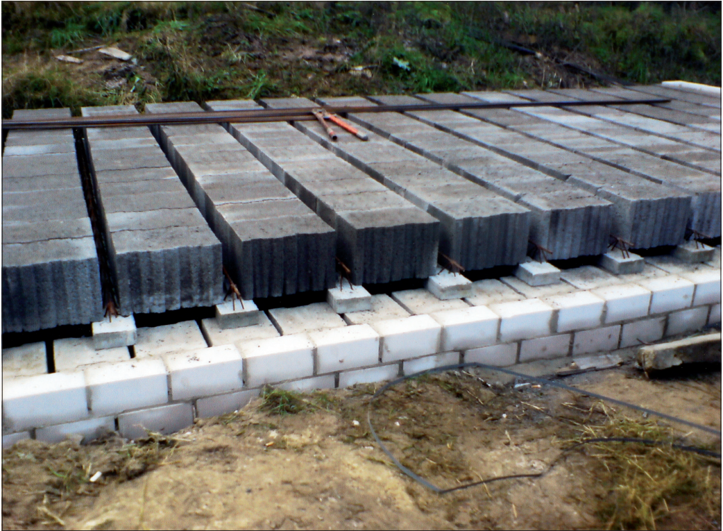
Abb. 6. Mit „Winklersteinen“ vorbereitete Kellerdecke am Keilberg. Aufn.: G. MAETZ.
