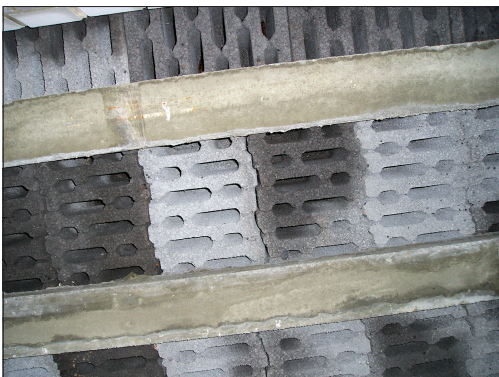
Abb. 7. Innenansicht der fertig gestellten Kellerdecke am Keilberg. Aufn.: G. MAETZ.
