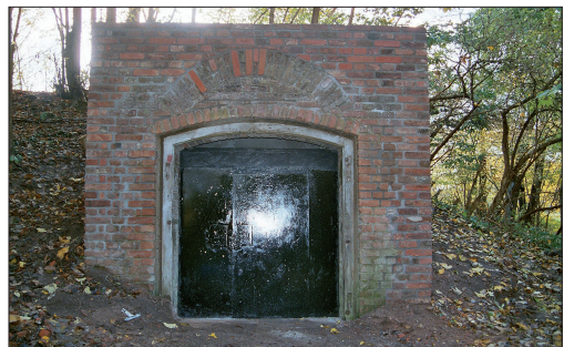
Abb. 12: Sanierter Kellerabgang. (Foto: J. Berg)
