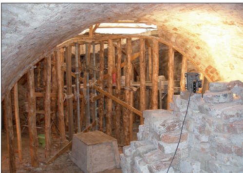
Abb. 3: Nahezu wiederhergestelltes Gewölbe mit Stützschalung. (Foto: J. Berg)
