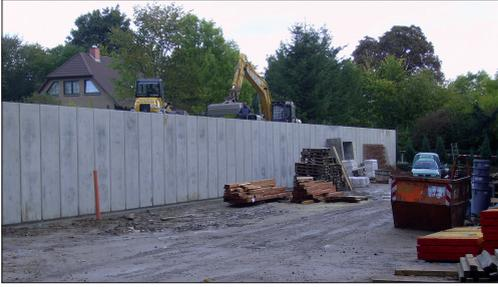
Abb. 9: Stützwand mit integriertem Zugangstunnel. (Foto: J. Berg)
