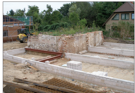
Abb. 8: Über der Geländeoberfläche hinausragender Kellerbereich. (Foto: J. Berg)
