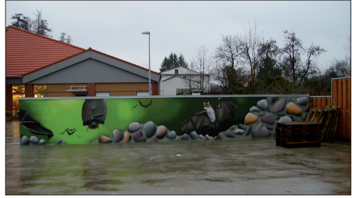
Abb. 10: Fledermausgraffiti an Kellerwand. (Foto: J. Berg)
