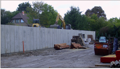
Abb. 9: Stützwand mit integriertem Zugangstunnel. (Foto: J. Berg)
