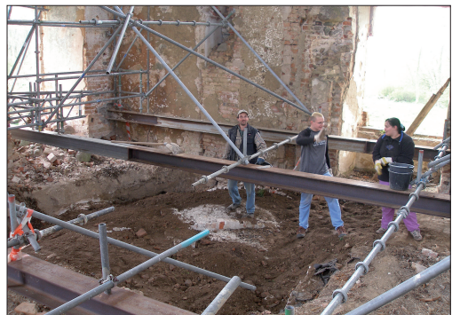
Abb. 4: Aufbringen der Frostschutzabdeckung in Handarbeit. (Foto: J. Berg)
