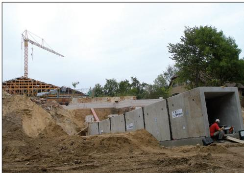
Abb. 7: Zugangs- und Einflugtunnel. (Foto: J. Berg)
