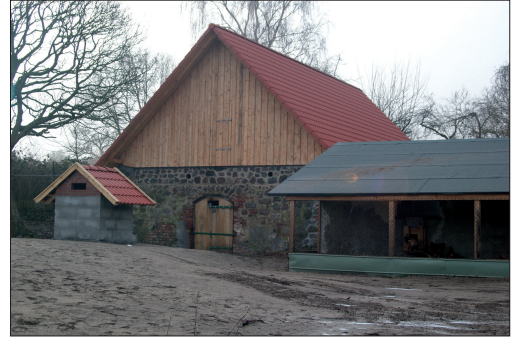
Abb. 6: Sanierter Eiskeller. (Foto: J. Berg)
