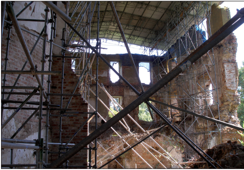
Abb. 1: Joachim'sbau ruine Putzar mit Notdach. (Foto: J. Berg)
