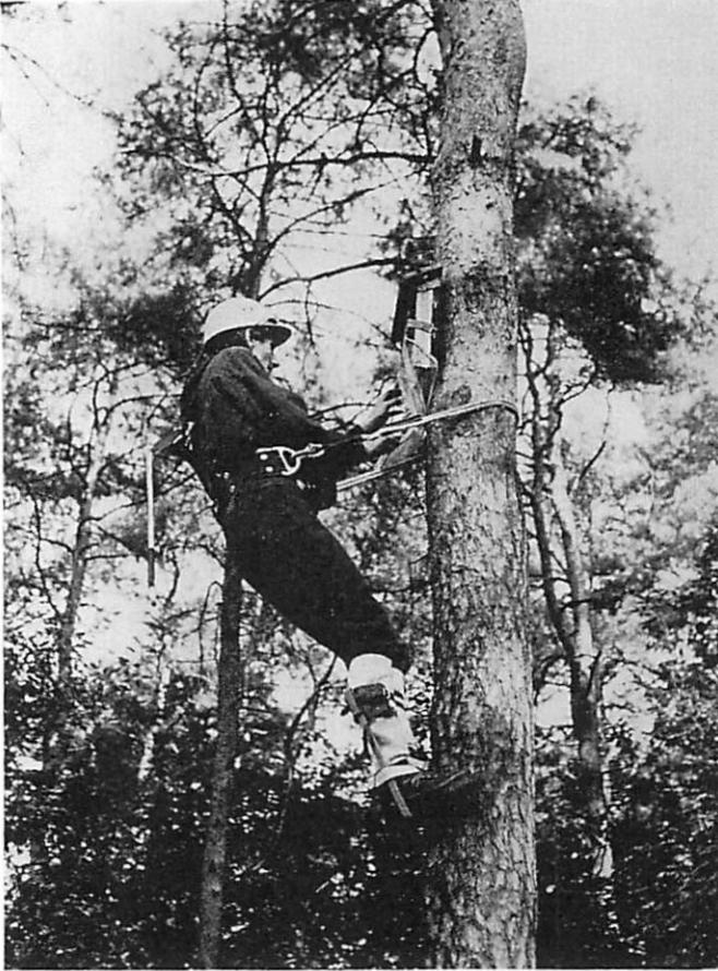
Abb. 13. Besteigen einer Kiefer mittels Zapfenpflückerausrüstung und Anbringen des Fangbeutels an einem FS 1-Kasten. Fehler: Kinnriemen nicht geschlossen!
