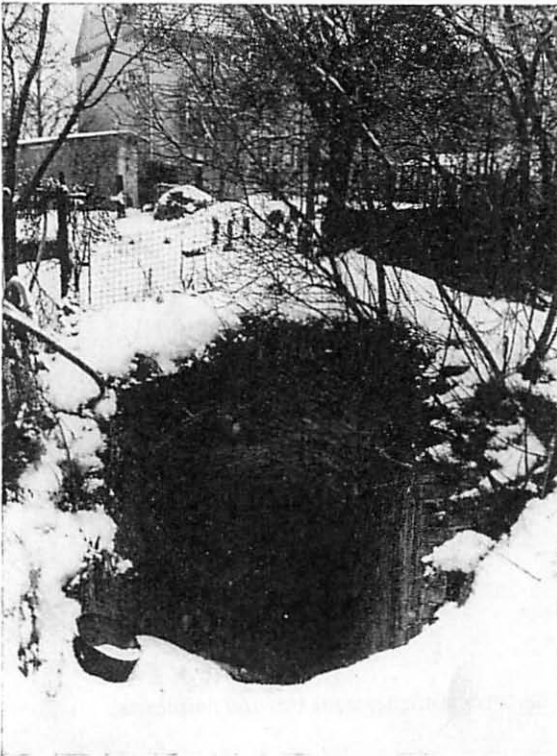
Abb. 2. Eingangsbereich des Eiskellers in Ludwigslust. Das gesamte Quartier ist mit Backsteinen ausgemauert. Aufn.: U. BINNER
