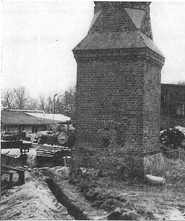
Abb. 1. Fundstelle von Plecotus auritus bei den Ausschachtungsarbeiten in Malchow. Aufn.: W. OLDENBURG
