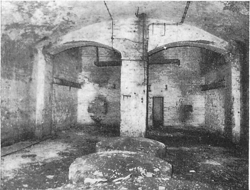
Abb. 1. Eins der Hallengewölbe (Raum III) in der alten Brauerei Frankfurt/O. Aufn.: R. Nest
