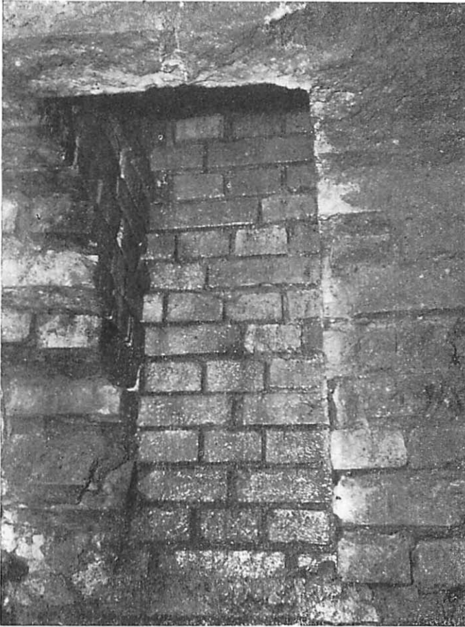
Abb. 2. Füllschacht in der alten Brauerei in Frankfurt/Oder (Raum III a). Aufn.: R. NEST
